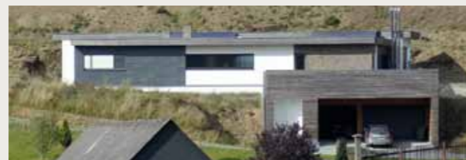
Neubau Wohnhaus, Ludwigstadt
