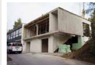
Büroanbau in Oberköblitz
