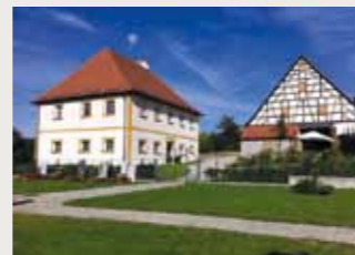
Sanierung Pfarrhof und -scheune
